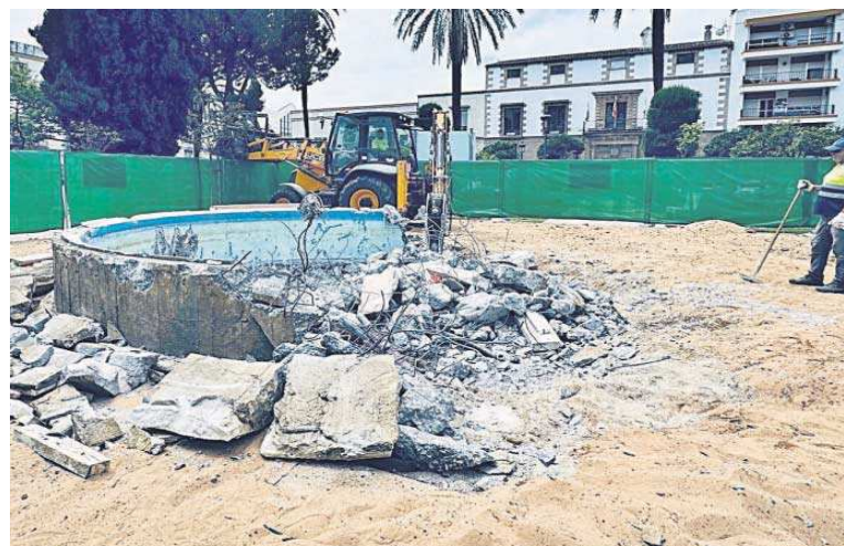
Estado actual de la fuente tras el inicio de los trabajos.
